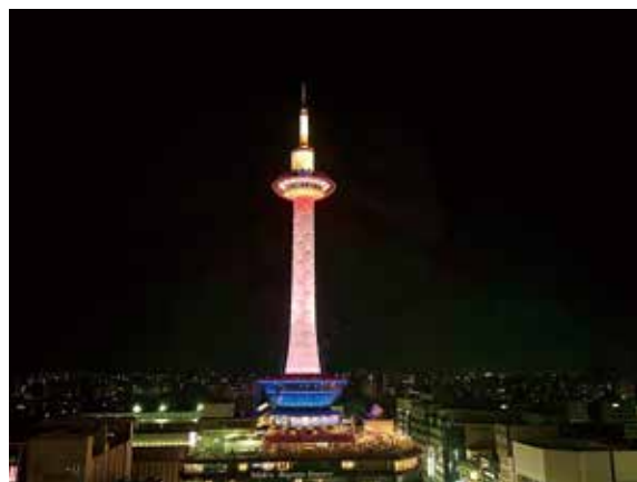
京都塔高131公尺，是京都市區最高的建築物也是車站地區最知名的地標
